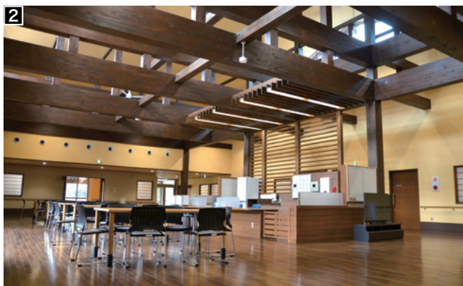
1 栗林市長をはじめとする関係者によって行われたテープカット 2 建材に秋田県産の木材をふんだんに使った木造平屋建ての新施設。写真は明るく開放感あふれる食堂スペース
