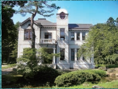
重要文化財 旧池田家住宅洋館
