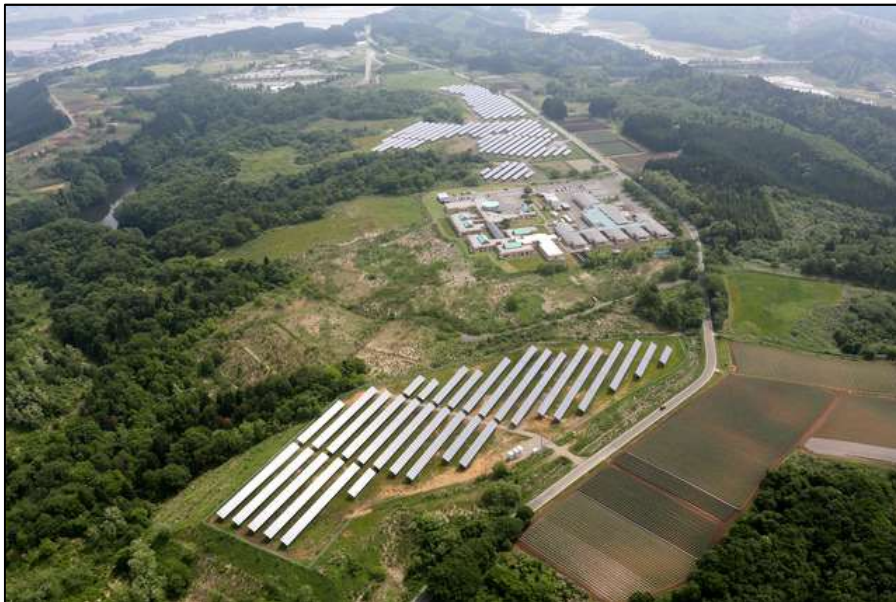
図1-19 大仙市柏台太陽光発電所
