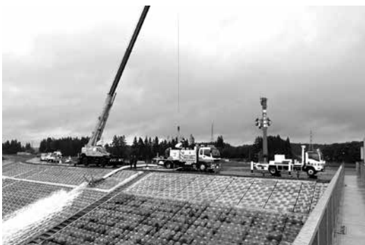
内水の排水作業の様子
