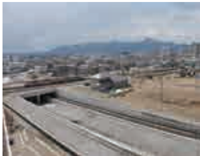
【写真】23年度から整備が進められている中通線
