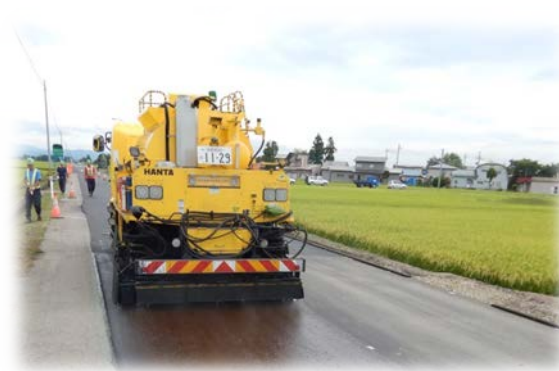
追分板杭線外1路線路面修繕工事
