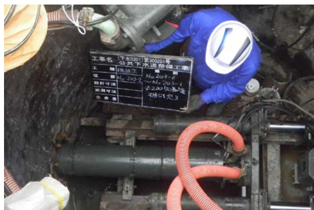
推進施工状況
