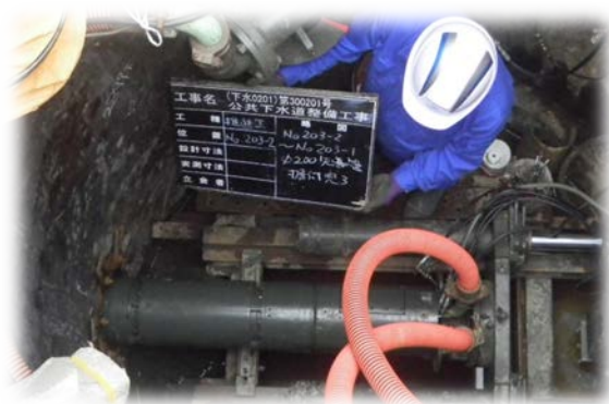
公共下水道整備工事
