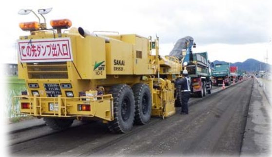
橋本幹線路面修繕工事
