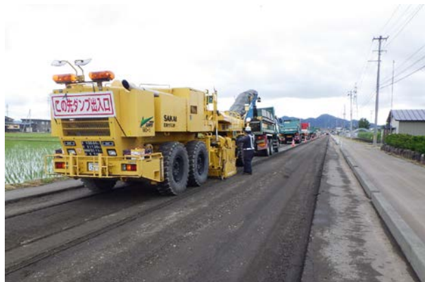
舗装剥ぎ取り状況写真
