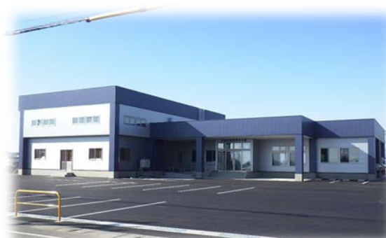
中仙公民館清水分館新築(建築)工事
