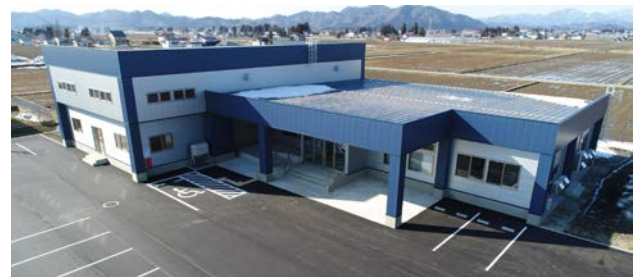
外観完成写真(ドローンによる撮影)
