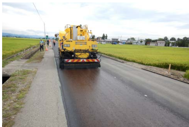
付着防止型乳剤散布状況写真
