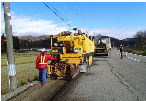
路面切削機による既設舗装撤去状況
