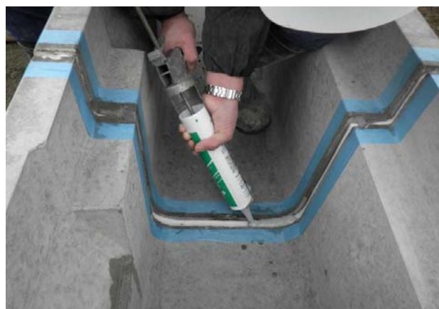
伸縮目地施工状況
