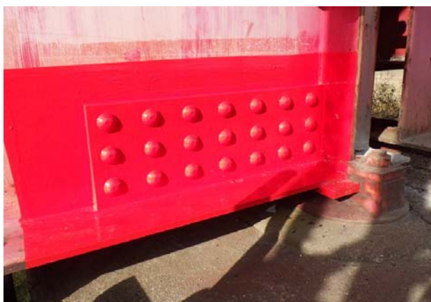
当て板補修工完成写真
