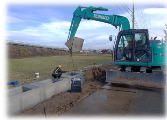
高畑新山線・茶畑2号線歩道整備工事
