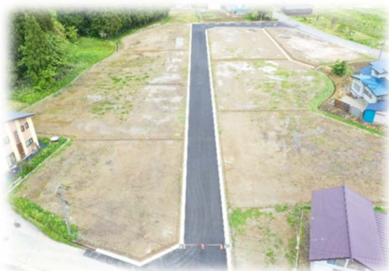
岩瀬・湯野沢地区道路等整備工事
