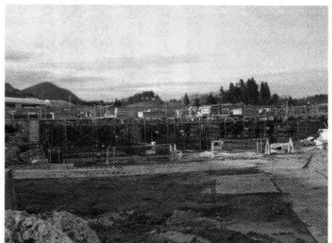
順調に工事が進む(仮称)大曲・南外学校給食センター
