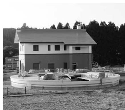
公共下水道県代行工事で実施されている南外浄化センター
