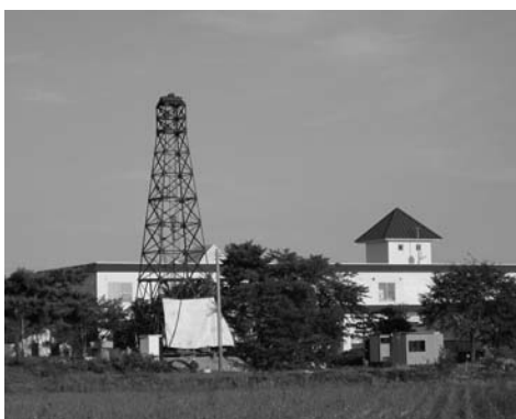
かみおか温泉嶽の湯で行われている復旧工事
