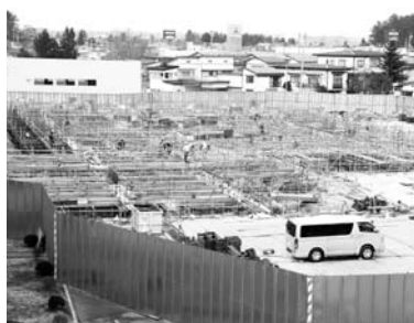
施工中の大曲中学校屋内体育館(4/6)
