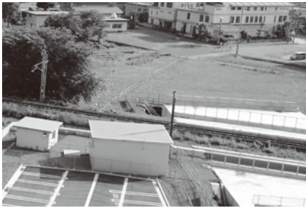
都市計画道路「中通線新設工事」の大曲黒瀬町地内
