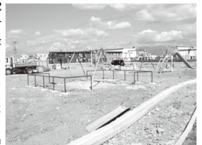
工事中の「しあわせ公園」
