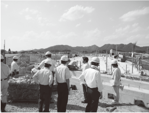
桁架設工法が変更され実施された 市道中仙4号線館ノ内北川橋橋梁上部工事
