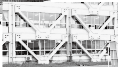
▼大曲小学校で施工したピタコラム工法
