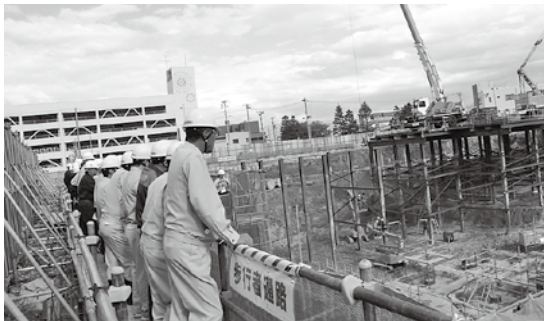
▶病院の工事状況を視察する企画産業常任委員
