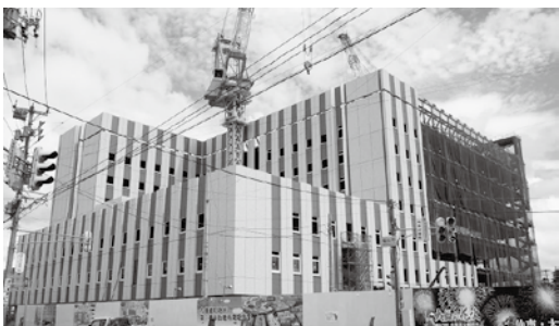
▲建設中の仙北組合総合病院
