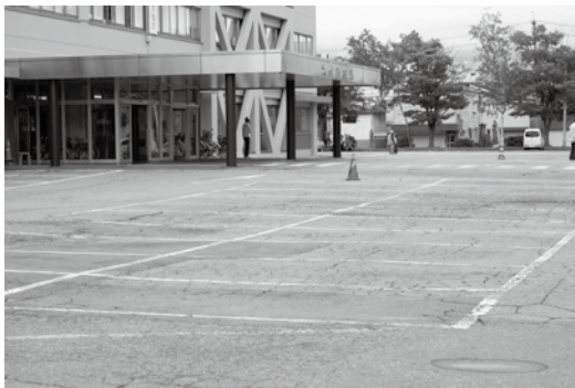
▲補修される市役所大曲庁舎駐車場
