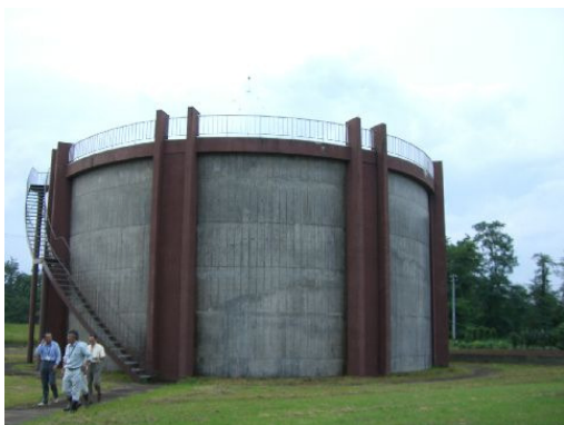
写真 7 玉川浄水場配水池
