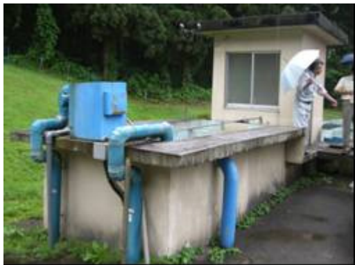
写真1 宇津台浄水場混和池
