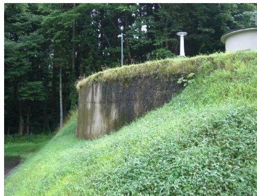
写真 6 宇津台配水池 (RC 造)
