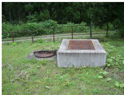
写真 24 宮ヶ沢配水池
