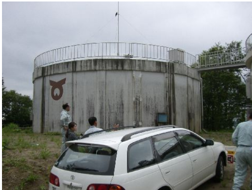
写真 13 刈和野 1 号配水池
