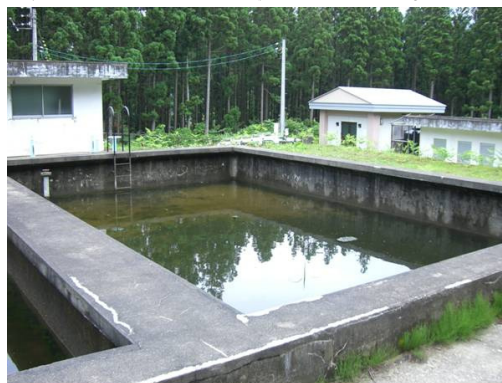
写真 20 宮ヶ沢浄水場（緩速ろ過池）
