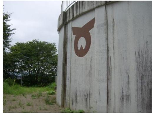
写真 14 刈和野 1 号配水池
