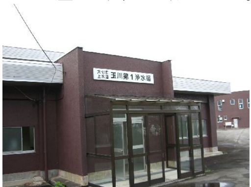
写真3 玉川第1浄水場
