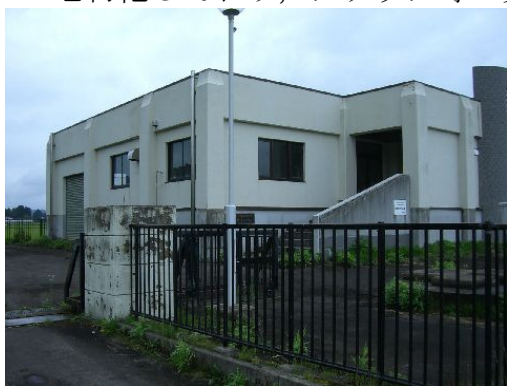
写真 25 南檜岡浄水場
