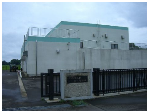
写真 9 北檜岡浄水場
