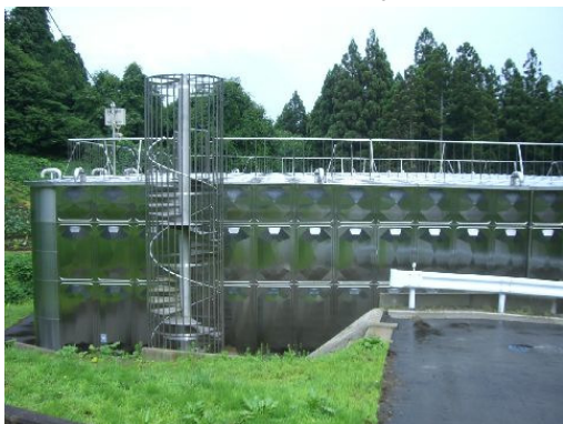
写真 5 宇津台配水池 (SUS 製)
