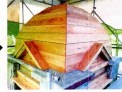
小屋組に野地板を 張ります
