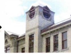
建物の下から 見上げた完成ドーム
