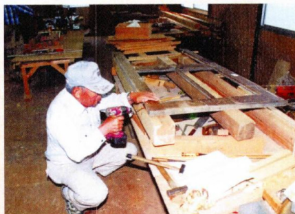
建具の補修作業
