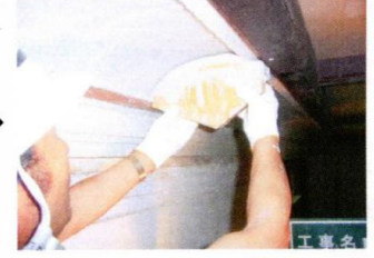
漆喰天井蛇腹は引き型という コテで仕上げる
