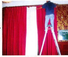
カーテンの吊り込み作業
