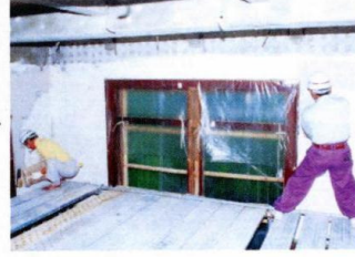
壁漆喰の下塗り
