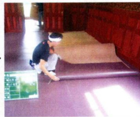
リノリウムの敷き込み作業
