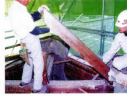
仮組みし合掌の高さを推定
