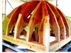
ドームの小屋組 (合掌トラス)
