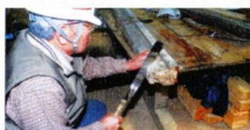
部材の破損部を切除し仕口を刻む。
