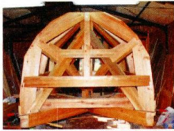
加工小屋で仮組みして 納まりを確認
