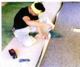
カーペットの敷き込み作業
