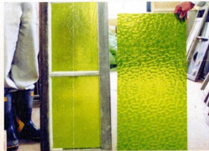
建物に残っていた型ガラス(左)と 取替用に新たに探した型ガラス(右)
