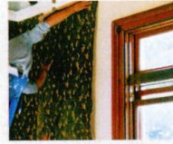
完成した金唐革紙は1・2階食堂室の壁に貼り込まれた
