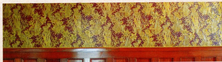
貼り込み完了状況(1階食堂兼音楽室)
