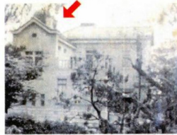
創建の頃の古写真 (矢印がドーム)
