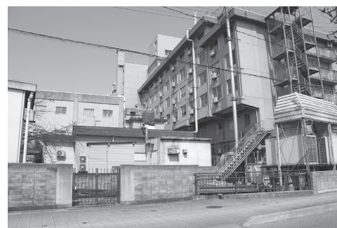
▲平成26年度で解体される南街区
