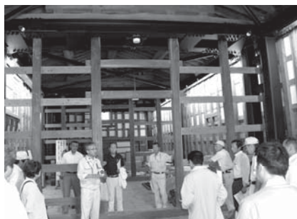
▲旧池田氏庭園 米蔵の修復状況
