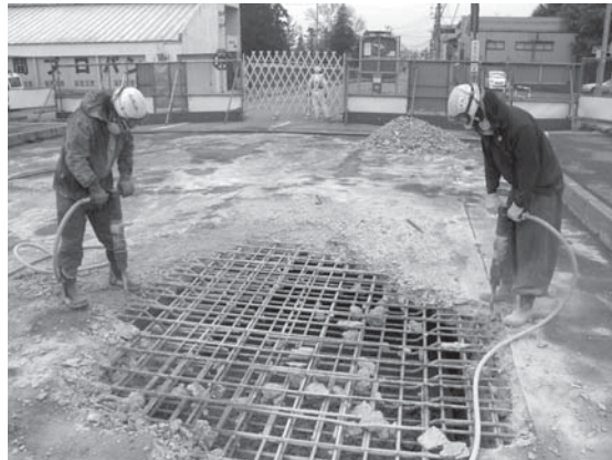
▲館の橋の長寿命化工事
