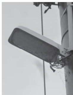
▲設置が進むLED街灯
