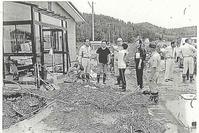
協和下淀川地内 被害状況の間取り
