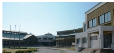
[写真] 公文書館として生まれ変わる予定の旧双葉小学校
