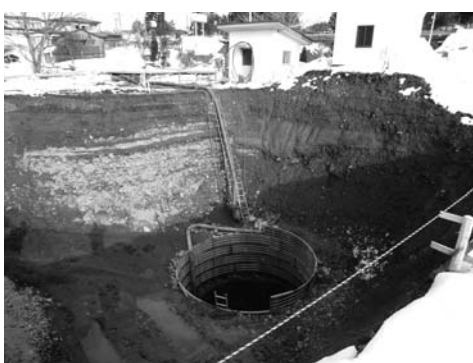
◀協和中央地区簡易水道の取水井戸掘削工事
