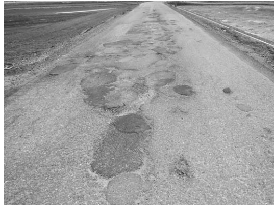
▲穴埋め補修をした市道
