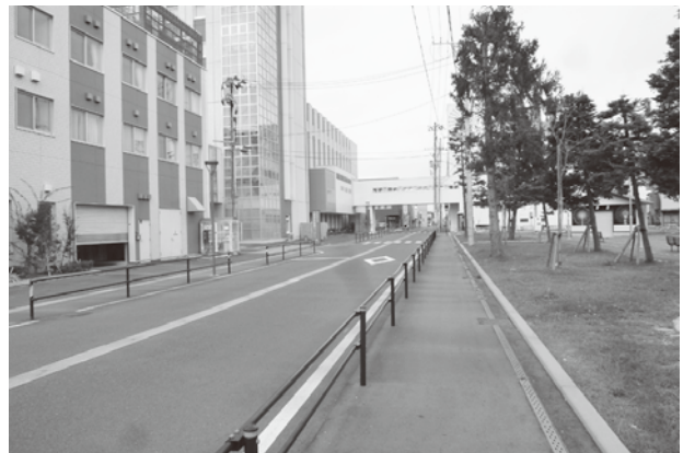
消雪施設が整備される駅前10号線
