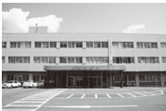
大仙市役所 本庁舎（大曲庁舎）
