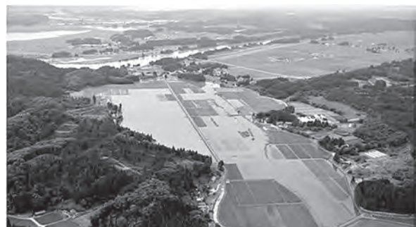
河川の氾濫状況
