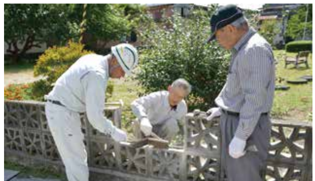
傷んだブロック塀を補修する組合員
