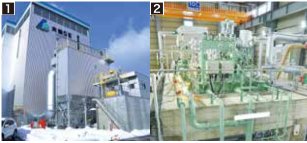
1 協和発電所外観 2 竣工式に合わせて公開された施設内部
