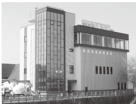
開館に向け、工事が進む 花火伝統文化継承資料館
