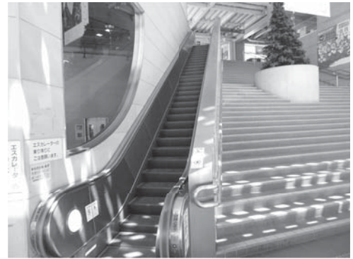
大曲駅エスカレーター
