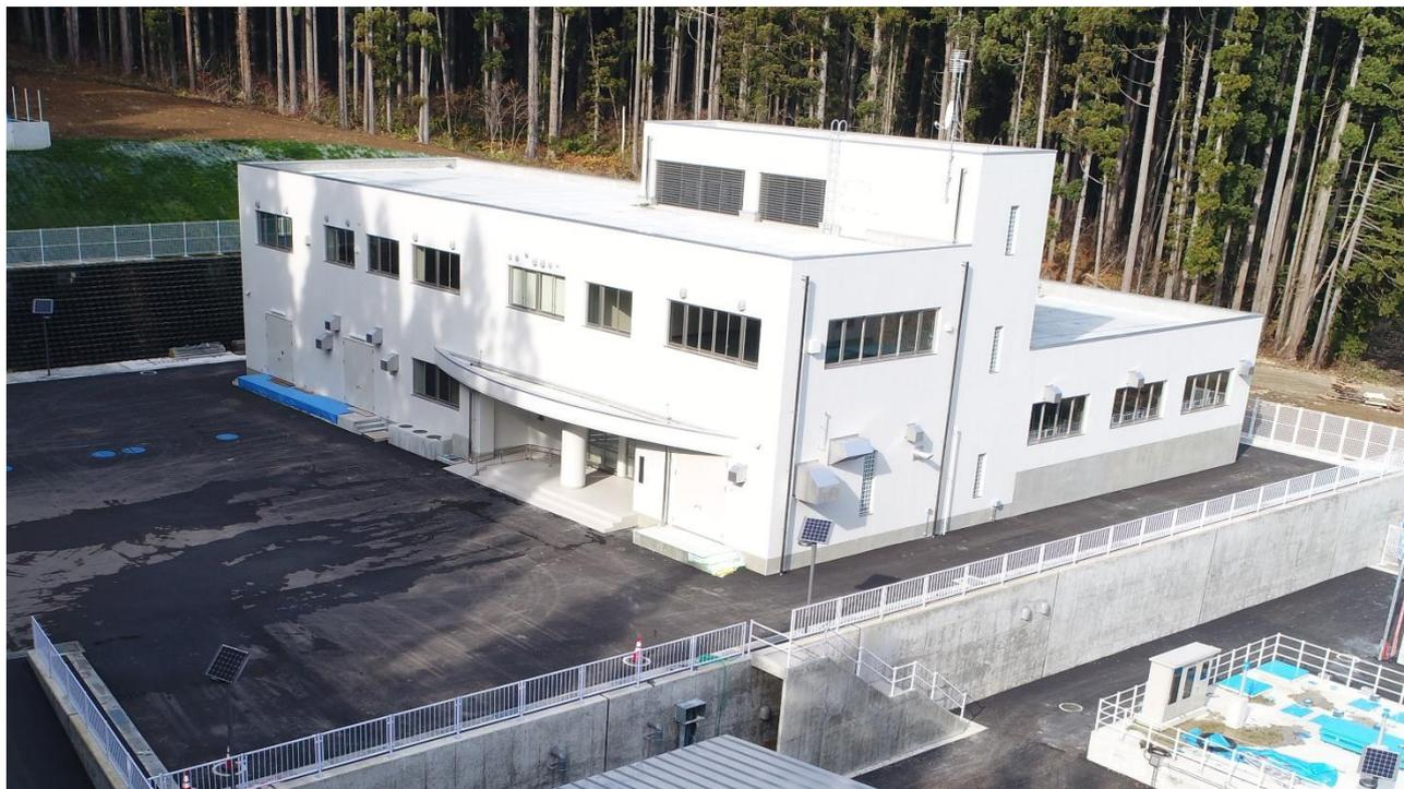
令和2年3月に完成した新しい宇津台浄水場は、雄物川の水と滝ノ沢の沢水と湧水を原水としています。滝ノ沢の沢水と湧水は、これまでどのような猛暑の時にも枯れたことがない貴重な水源です。二つの水源から採取された水の状態に合わせて処理する急速ろ過方式を採用しています。
