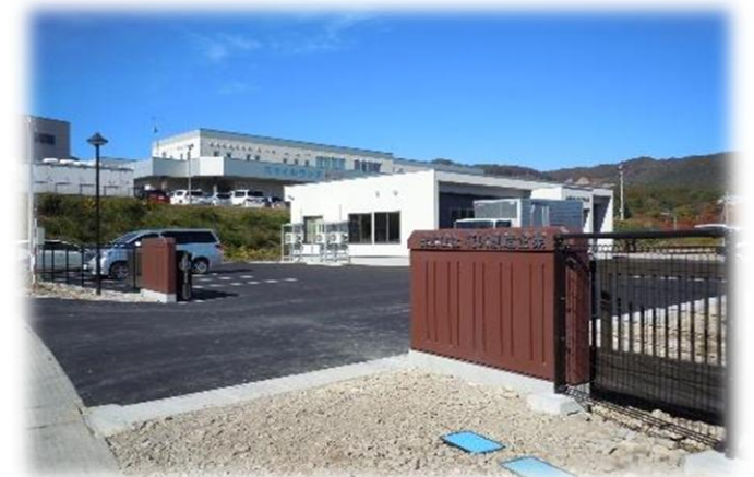
事務所棟(平成27年9月完成)
