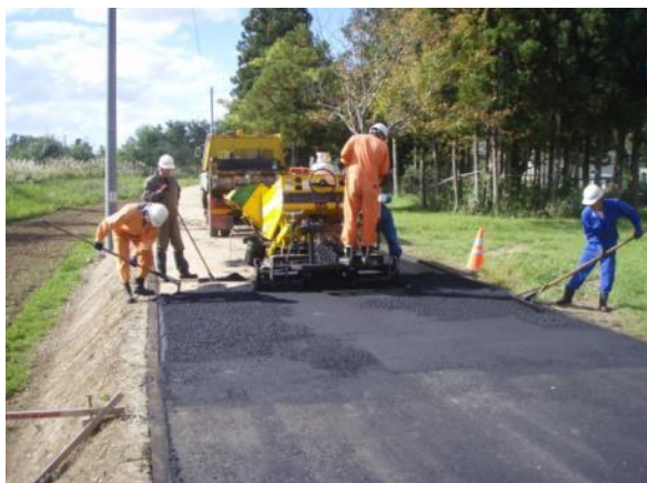
市の直営舗装工事
