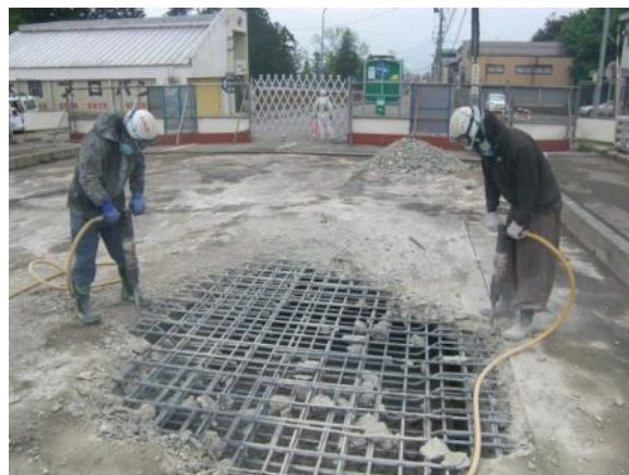
橋りょう長寿命化工事
