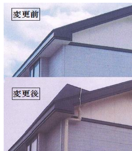
融雪設備の設置（屋根）
