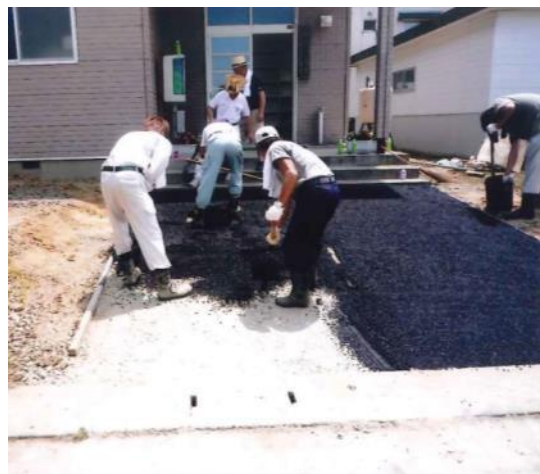
地域住民による自治会館入口の舗装作業
