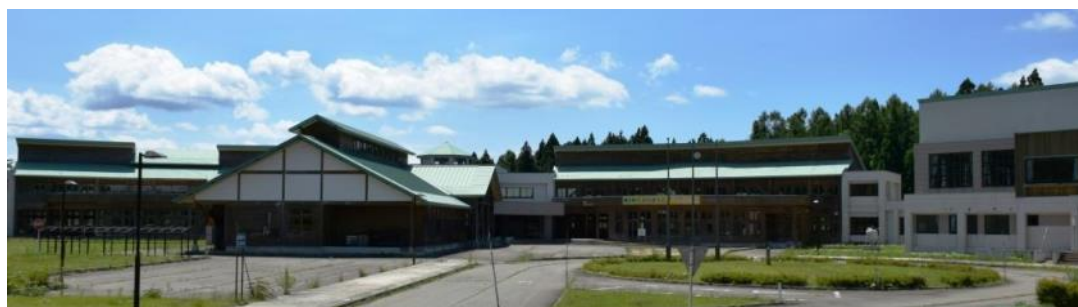
旧双葉小学校を改修した公文書館の設置（平成 29 年度完成予定）
