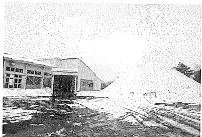
解体後の旧公民館 現在、空き地は雪捨て場として利用
