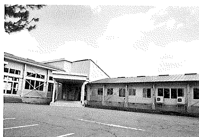
解体前の旧公民館
