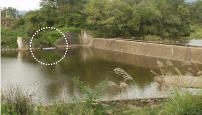
現在の上堰 (写真白丸内)、斉内川に落ちてサイフォン式で左岸の水路に出る。
