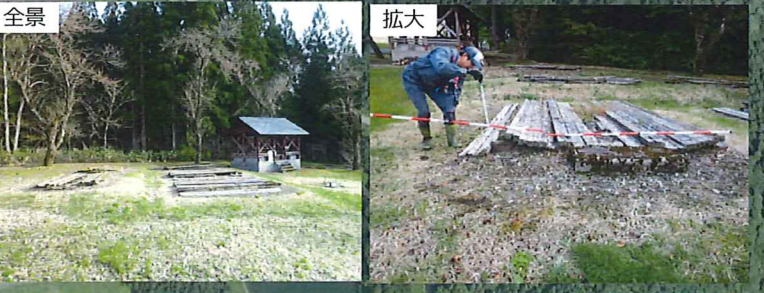
キャンプ場整備・・・ウッドデッキ撤去・整地・芝張り
