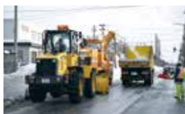
雪が降らなくても、深夜の出勤があっても、日中は道幅が狭くなった箇所や一時堆雪場の除排雪を行い、道路維持や安全確保のため作業に徹する(上) 同じ路線でも雪質や降雪量により環境が変わる。臨機応変かつ限られた時間の中で行われる除雪作業(右)
