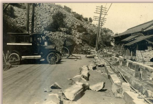
横須賀の崖崩れ
