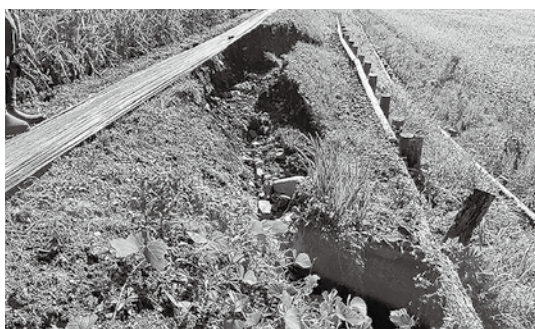
大雨により崩落した畦畔
