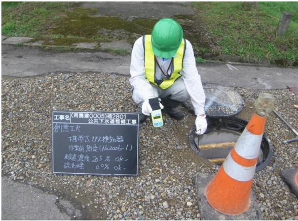
携帯式ガス検知器
