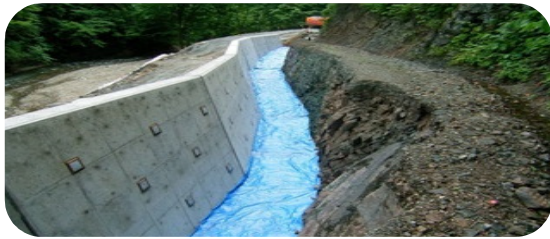
真木線道路災害復旧工事
