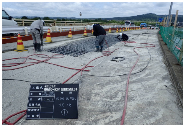
床版取壊し状況
