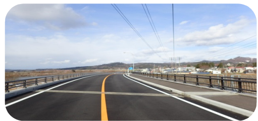
暁橋橋梁補修工事
