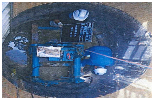
平成28年度受賞 公共下水道整備工事 推進（発進立孔）作業状況
