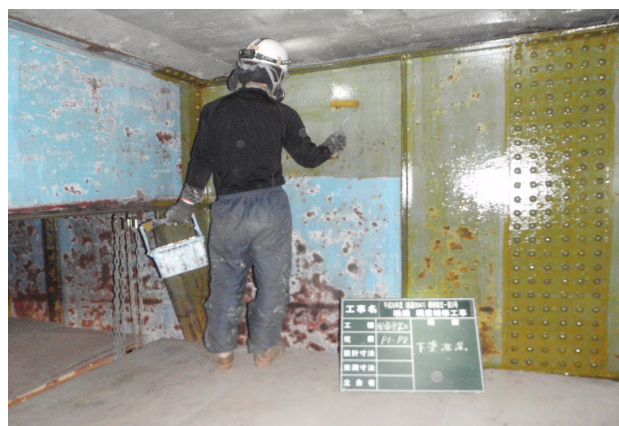
現場塗装下塗り施工状況
