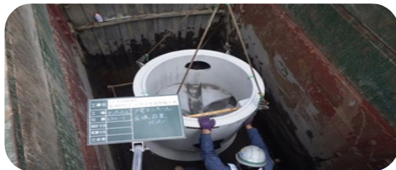
公共下水道整備工事
