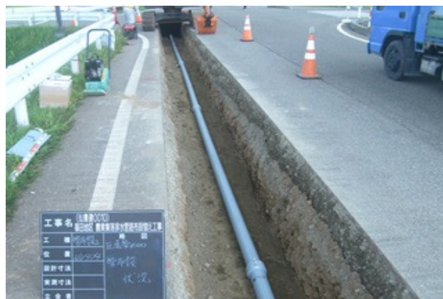
管路工施工状況
