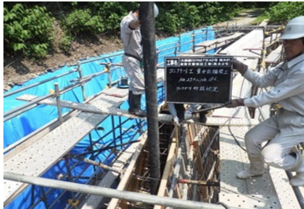
重力式擁壁工施工状況
