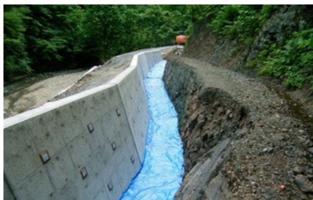
平成30年度受賞 真木線道路災害復旧工事(真木2号) 重力式擁壁工作業状況
