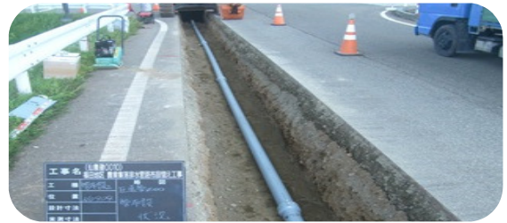
福田地区農業集落排水管路布設替え工事
