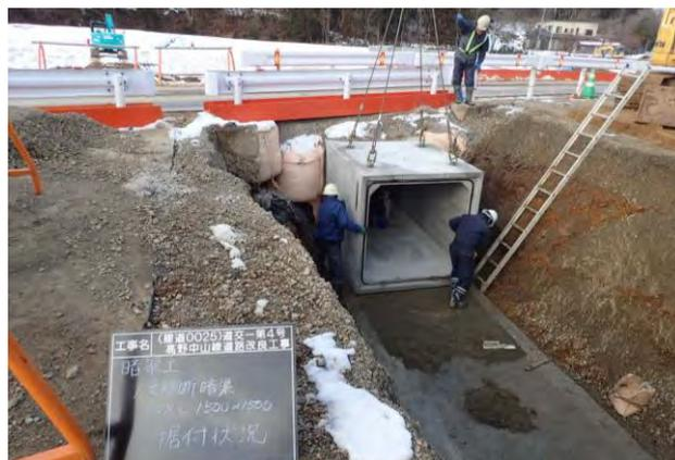
仮設道路設置後の横断暗渠布設状況写真
