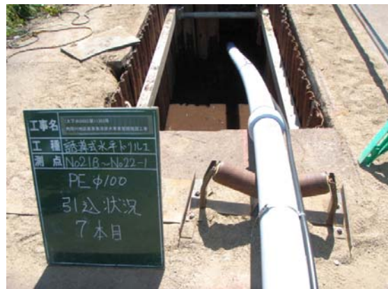
非開削誘導式水平ドリル工法
