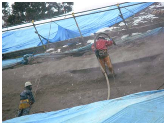
ソイルセメント下地処理
