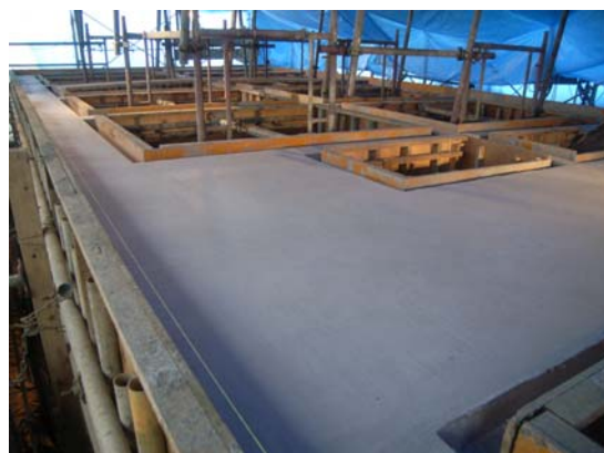
コンクリート養生
