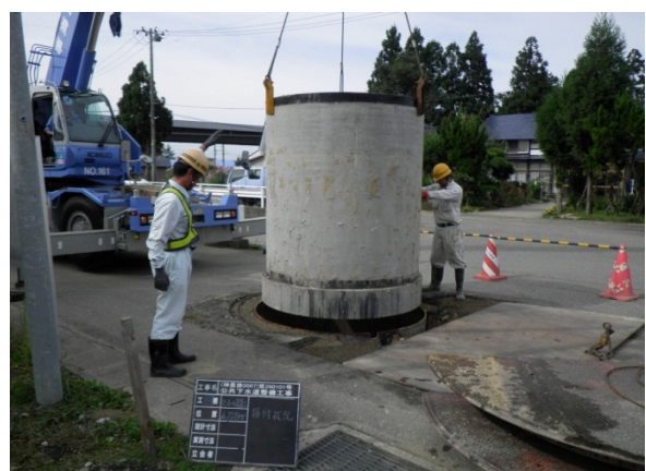
3号マンホール
