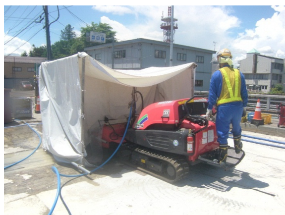
床版コン取り壊し (WJ工法)
