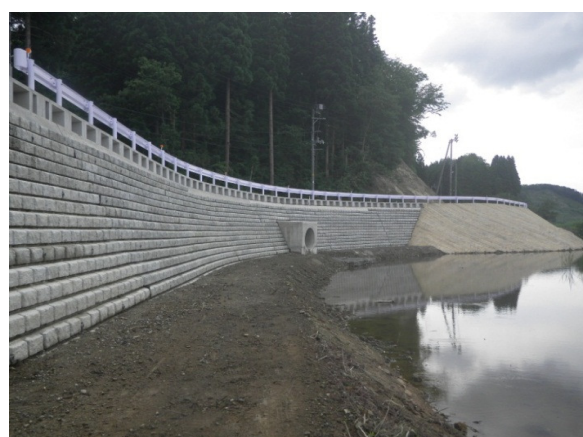
完成写真(擁壁工)
