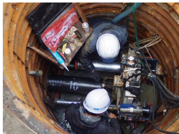
鋼管推進状況
