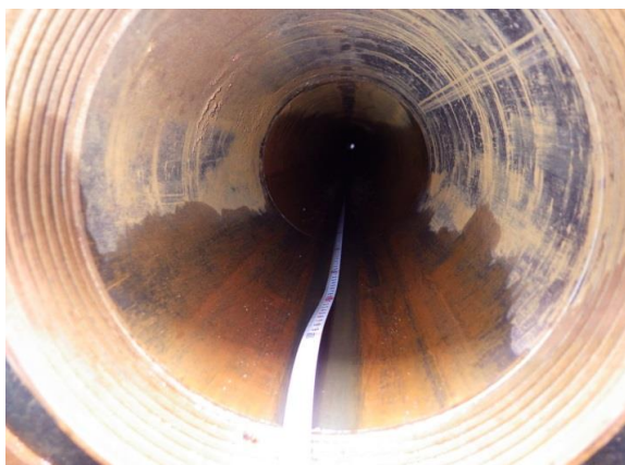
鋼管推進完了
