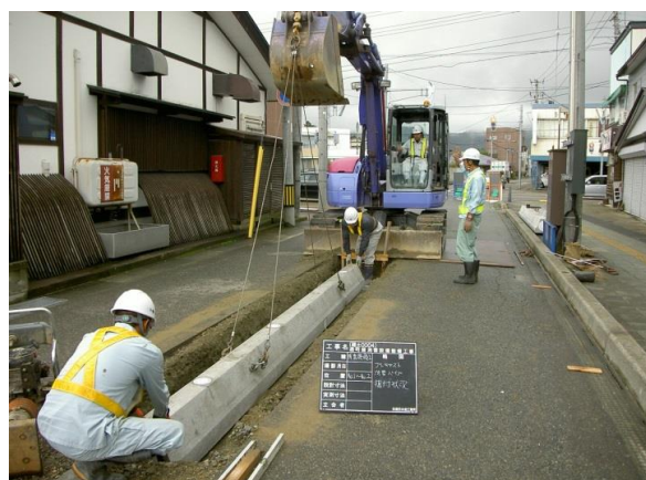
二次製品布設状況
