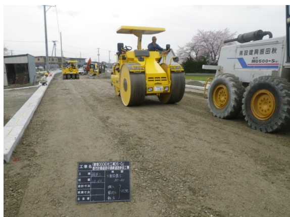
路盤工施工状況
