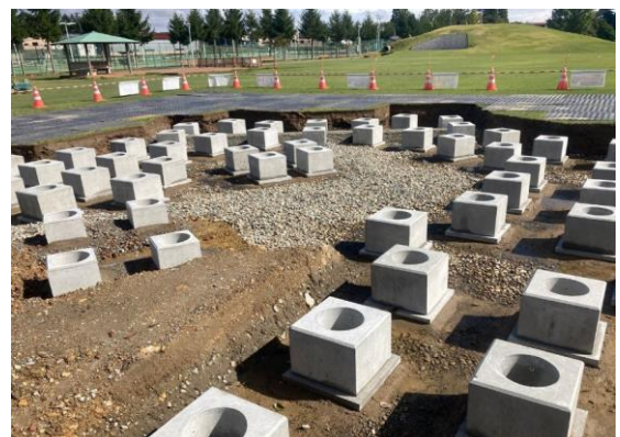
基礎ブロック設置完了
