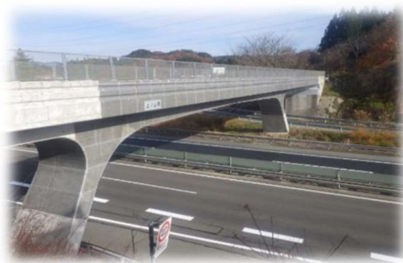
橋補修交一第2号 上ノ山橋橋梁補修工事
