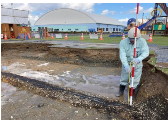
トータルステーション使用状況
