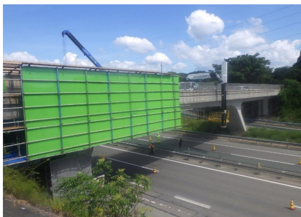
橋梁点検車を用いての足場架設（及び解体）
