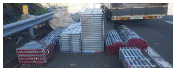
上)NETIS登録:吊足場「セーフティSKパネル」 下)NETIS登録:枠組み足場「NDシステムダーウィン」
