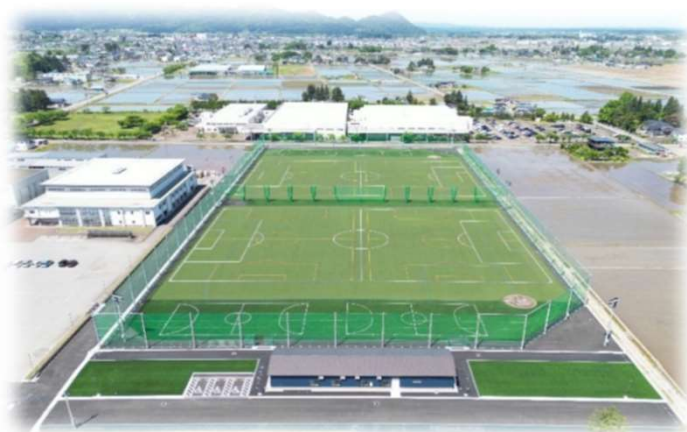
多目的人工芝グラウンド整備事業土木工事
